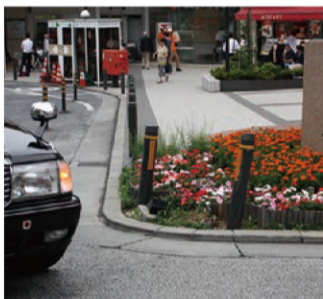
①内輪差による接触破損箇所
