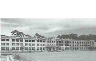
▲津波の後火災になった石巻市立門脇小学校
