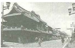
電柱も地下に埋設
